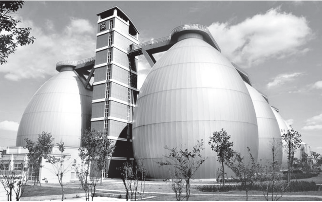
Hình 1. Hệ thống phân hủy kỵ khí bùn thải Bạch Long Cảng - Thượng Hải
